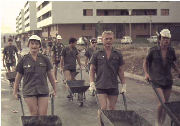
1968 г. Югославия. Строительство автомагистрали Белград-Загреб
